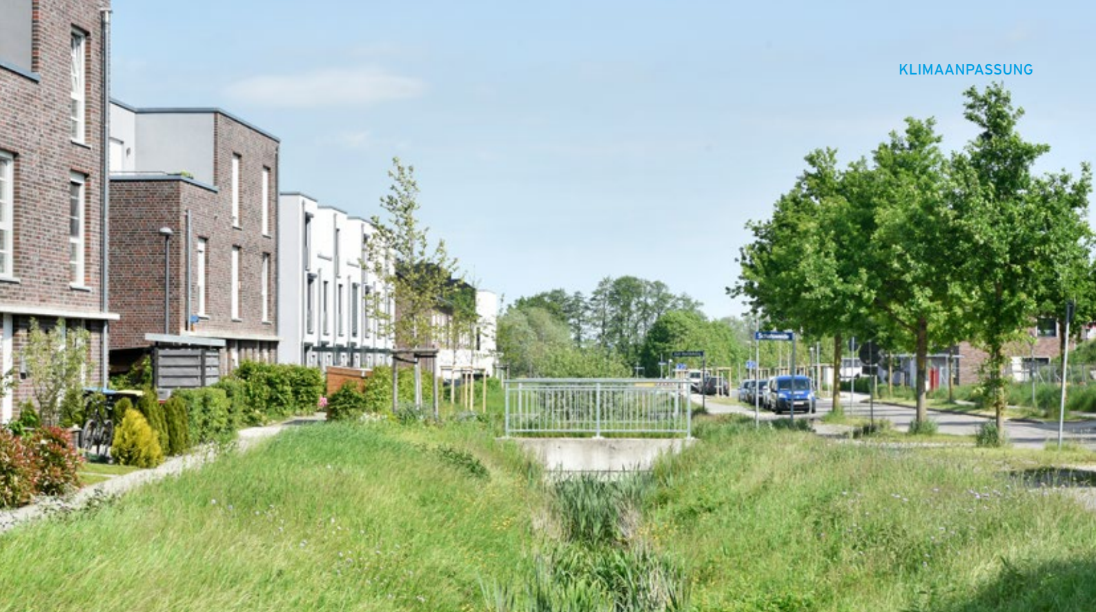
Begrünte oberflächennahe Entwässerungsmulde im IBA Hamburg Quartier Vogelkamp Neugraben
