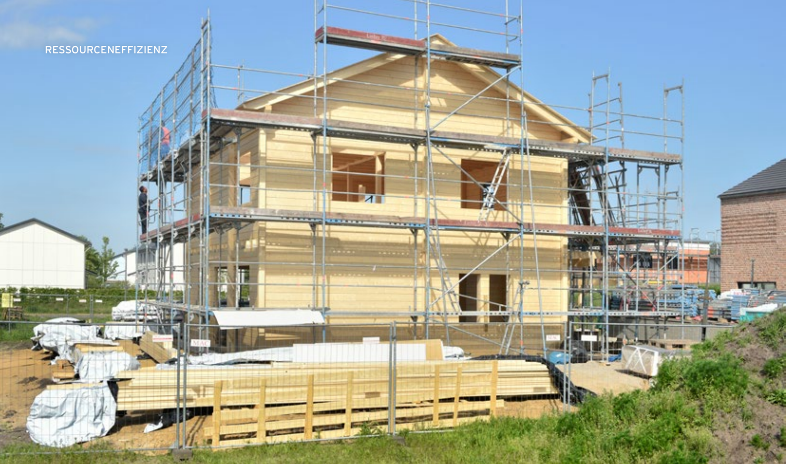
Holzmassivbau im IBA Hamburg Quartier Vogelkamp Neugraben
