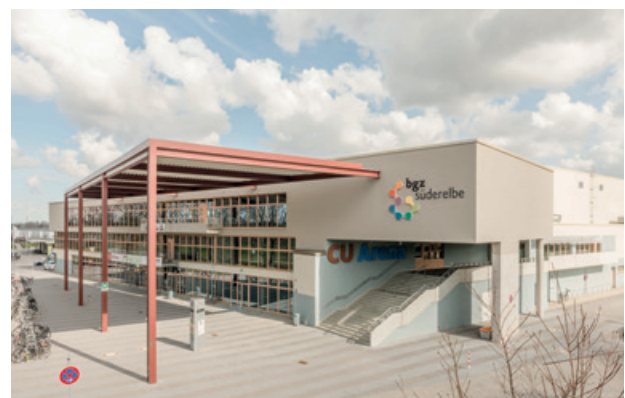
Das BGZ Süderelbe wurde 2012 eröffnet
