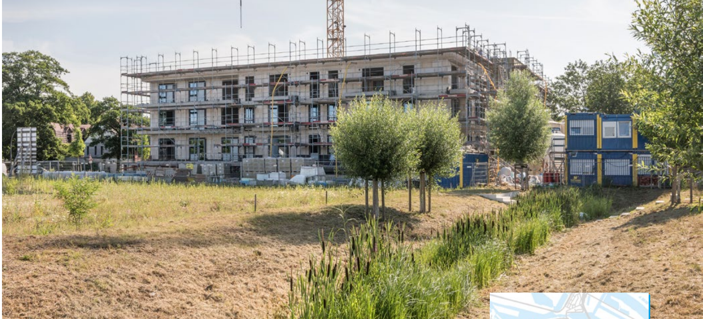
Baustelle der SAGA mit Landschaftsfinger im Vordergrund
