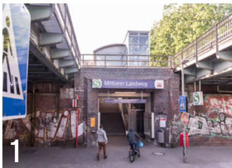
1 S-Bahnstation Mittlerer Landweg
