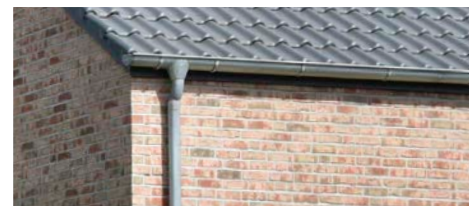
Abb. 58 | Fallrohr am Satteldach
