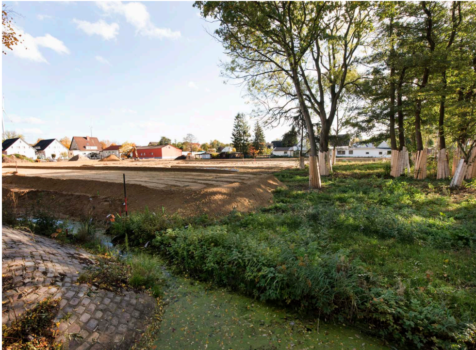
Abbildung 4 | Foto vom Baufeld GW-01 mit Blick nach Südosten (Oktober 2020)
