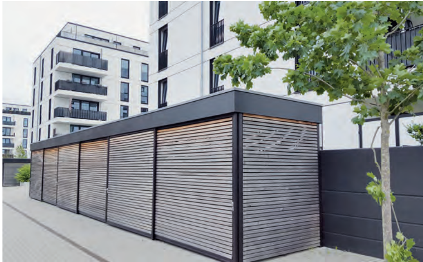
Abb. 4.9: Beispiel für das Parken auf dem Grundstück (GGR Planung)
