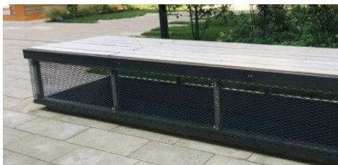
Abb. 116: Sitzelement mit seitlicher Lüftungsöffnung
