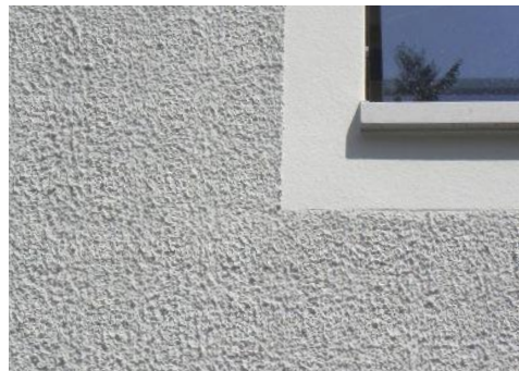
Abb. 29: Strukturierte Putzfassade auf massivem Ziegelbau
