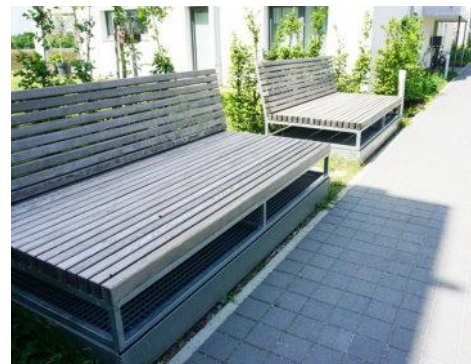
Abb. 118: Mit Sitzmöbel kombinierte Lüftungsöffnung
