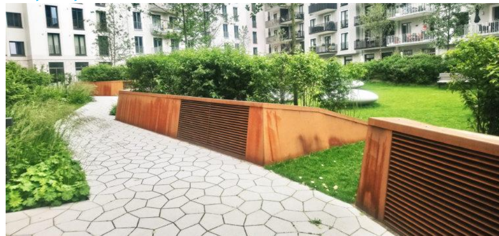
Abb. 119: Gestalterisch integrierte, begrünte Lüftungsöffnungen
