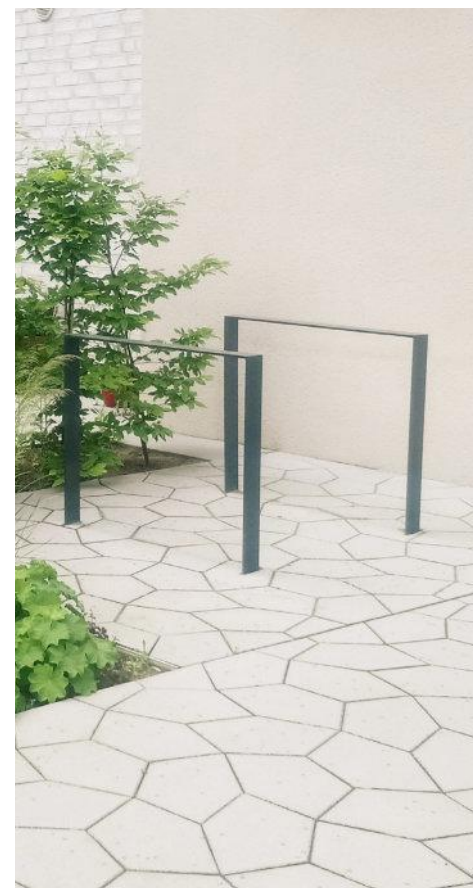
Abb. 113: Flachstahlfahrradbügel in Plattenbelag
