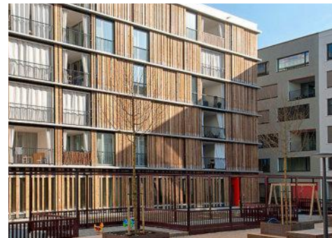
Abb. 30: Holzbau in Wolfertswil in der Schweiz
