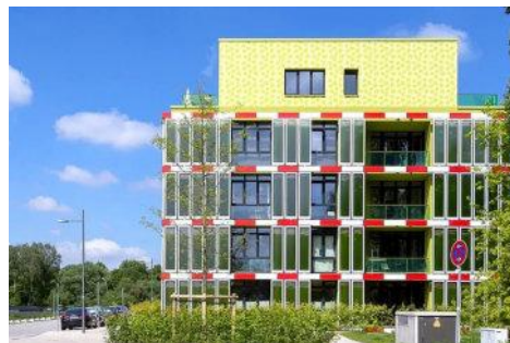
Abb. 125: Bioenergiefassade mit Mikroalgen (Splitterwerk Architekten, IBA Hamburg)
