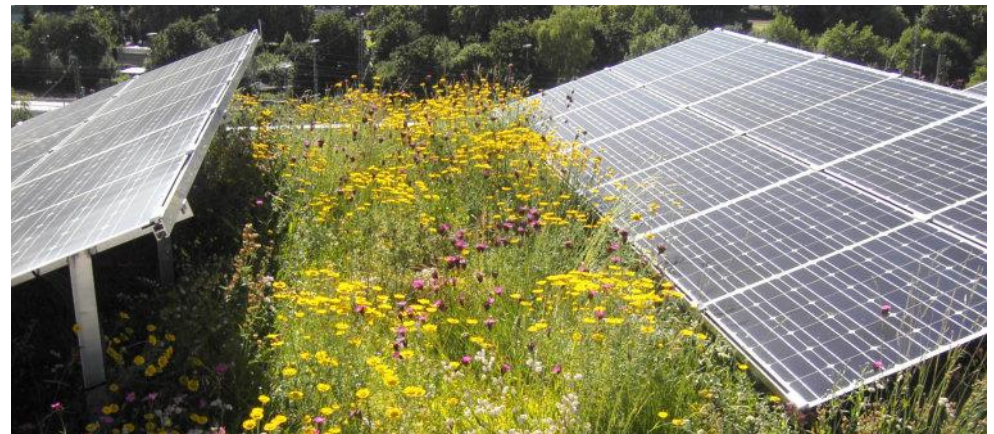
Abb. 54: Extensives Gründach mit kombinierter Energiegewinnung
