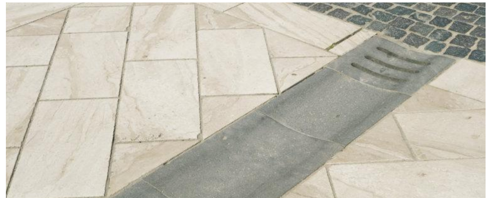
Abb. 107: Offene Entwässerung in hochwertigem Belag
