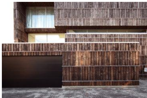
Abb. 124: Recyclingholz aus alten Kabeltrommeln als Fassadenmaterial (2012 Architekten)
