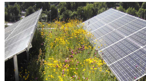
Abb. 23 | Dachbegrünung Flachdach mit Energiegewinnung
