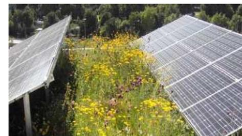
Abb. 23 | Dachbegrünung Flachdach mit Energiegewinnung
