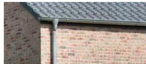
Abb. 58 | Fallrohr am Satteldach
