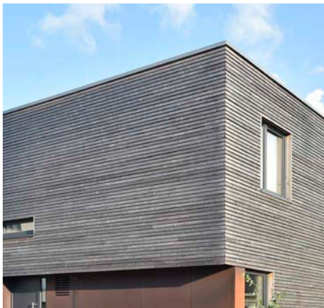
Abb. 44 | Holz als Fassadenverkleidung
