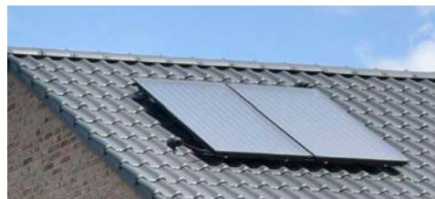
Abb. 25 | Beispiel Technikfläche Satteldach
