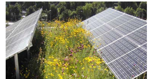
Abb. 23 | Dachbegrünung Flachdach mit Energiegewinnung
