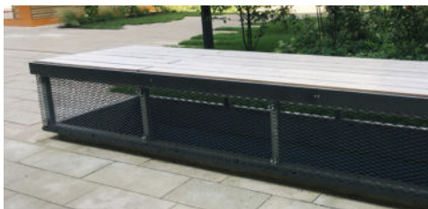
Abb. 116: Sitzelement mit seitlicher Lüftungsöffnung
