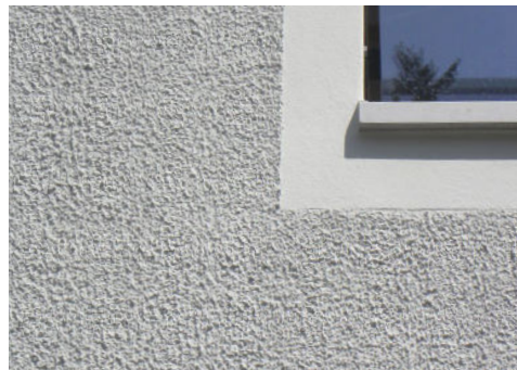
Abb. 29: Strukturierte Putzfassade auf massivem Ziegelbau
