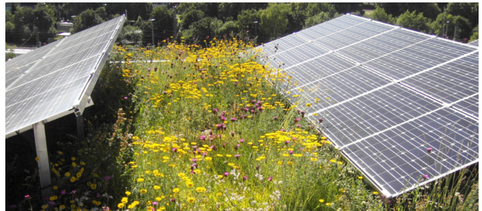
Abb. 54: Extensives Gründach mit kombinierter Energiegewinnung
