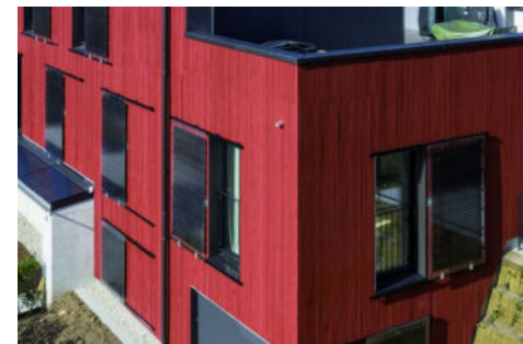
Abb. 126: PV-Schiebeelemente bei einem Plusenergiehaus (Vera Gloor Architektur)
