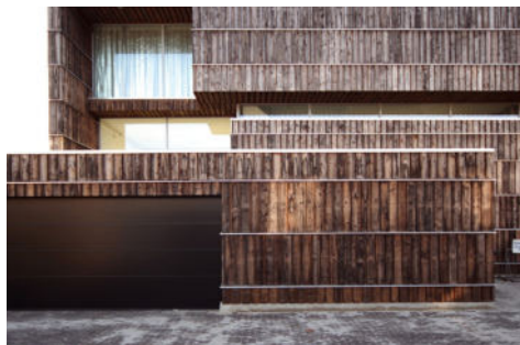
Abb. 124: Recyclingholz aus alten Kabeltrommeln als Fassadenmaterial (2012 Architekten)
