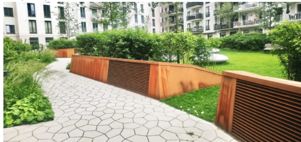
Abb. 119: Gestalterisch integrierte, begrünte Lüftungsöffnungen
