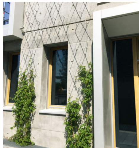
Abb. 44: Architektonische Integration der Rankhilfe
