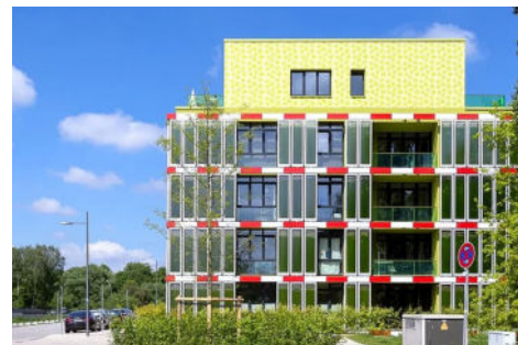
Abb. 125: Bioenergiefassade mit Mikroalgen (Splitterwerk Architekten, IBA Hamburg)
