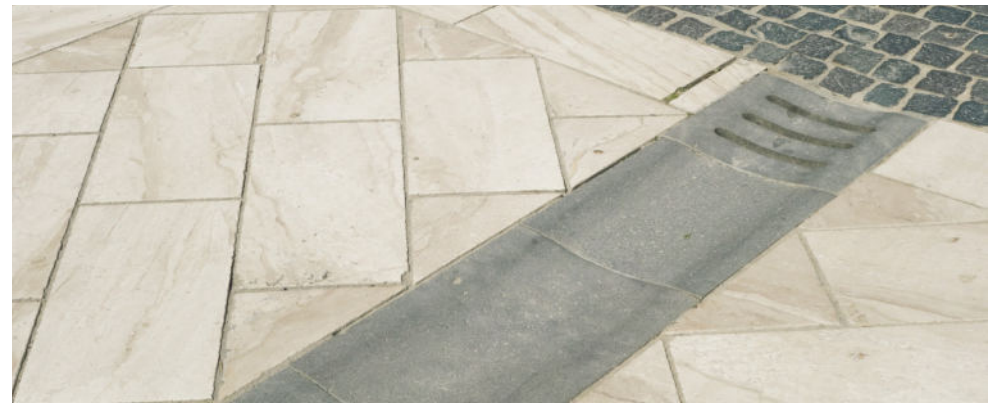
Abb. 107: Offene Entwässerung in hochwertigem Belag
