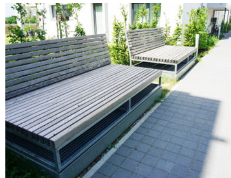
Abb. 118: Mit Sitzmöbel kombinierte Lüftungsöffnung
