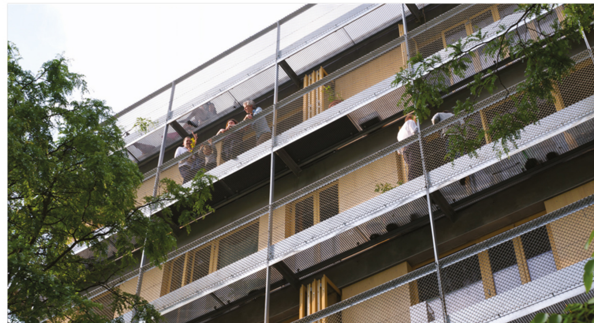
Umlaufende Balkone als Freisitz und zur Wartung
