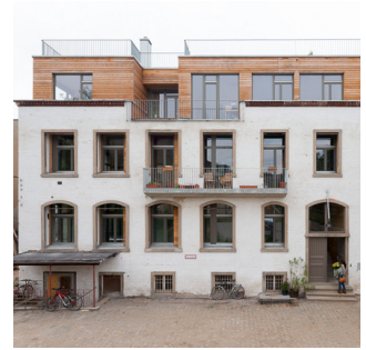
Wohnprojekt Tabakfabrik, Dresden
