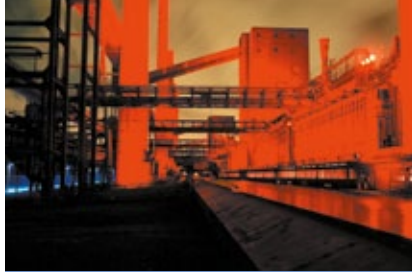
Kokerei (coking plant) Zollverein
