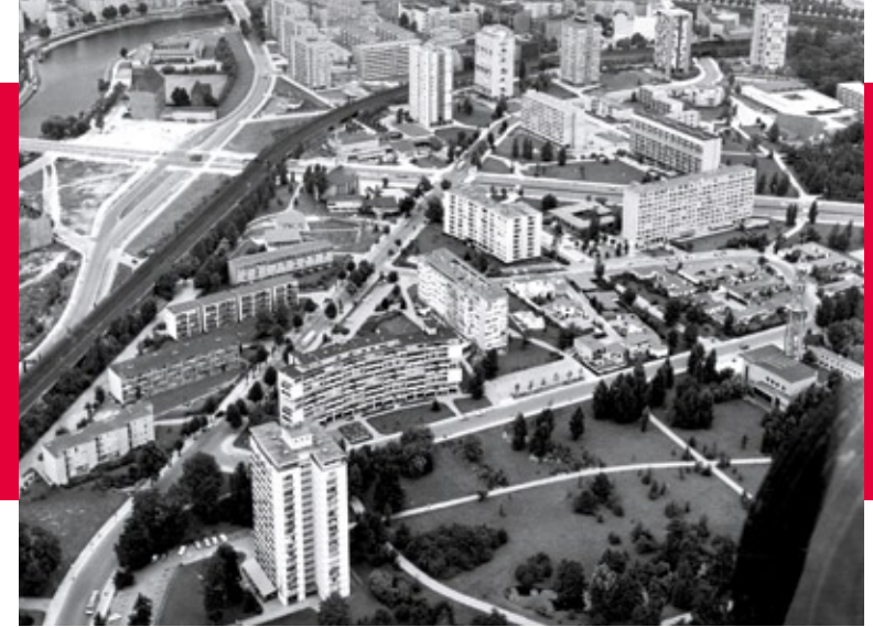
Vue aérienne du quartier Hansaviertel
