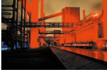
Kokerei (coking plant) Zollverein
